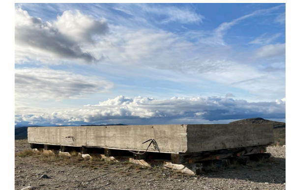
Betonfundament fra en amerikansk radarstation vest for Kangerlussuaq, tidligere Sønderstrøm Airbase
