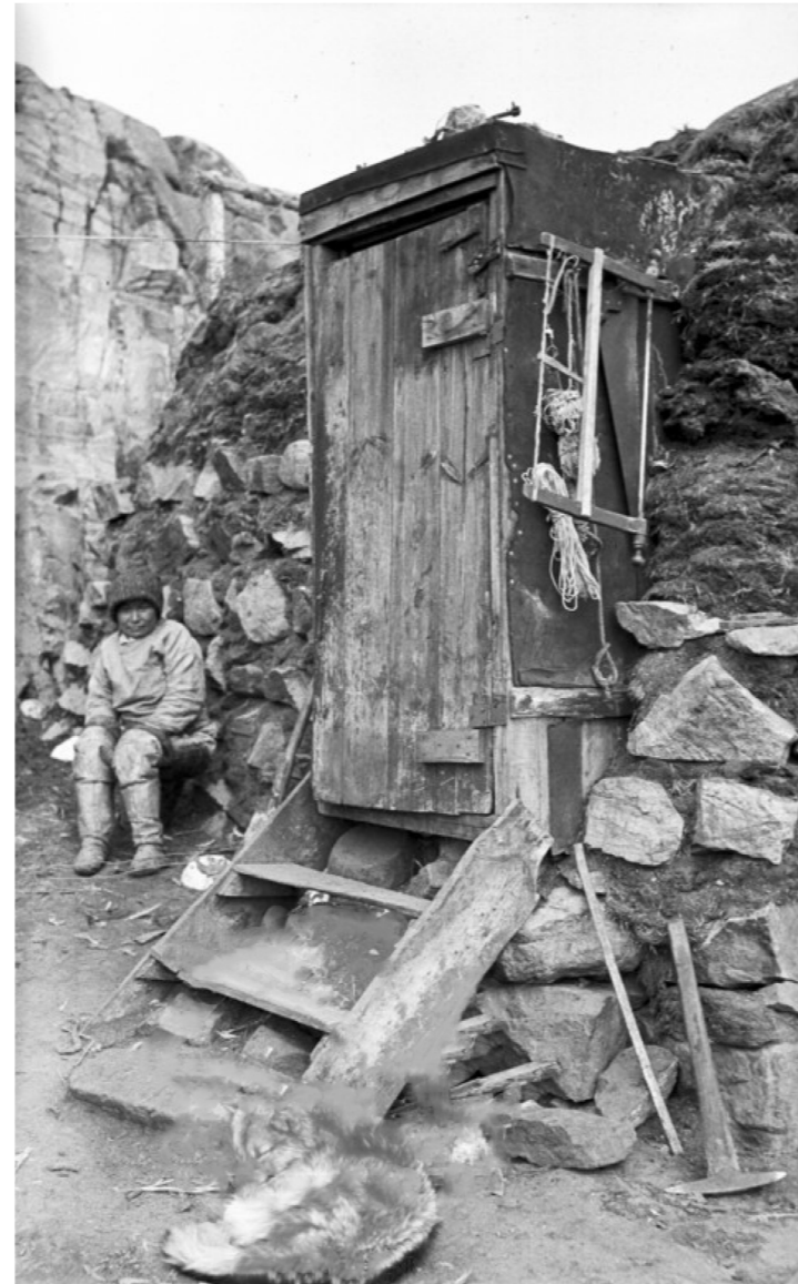
Vindfang til inuitisk bolig fra begyndelsen af det tyvende århundrede, bygget af genbrugte koloniale bygningsdele.
